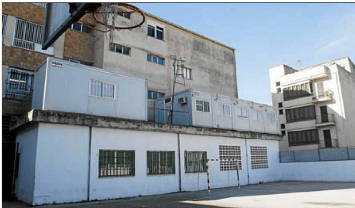
Las aulas prefabricadas del CEPA Llevant, adosadas a las instalaciones que se ve obligado a compartir con el IES Na Camel·la. / JORDI AVEL·LA
